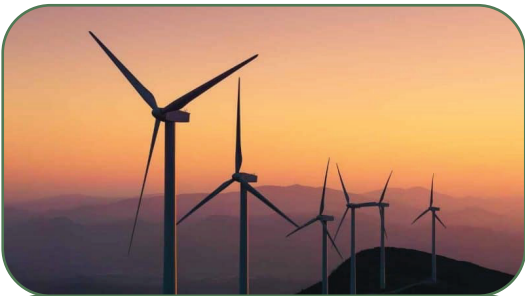
محطة دومة الجندل لطاقاة الرياح
